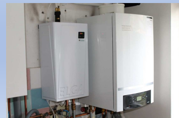
"hybride" (halve) warmtepomp CV-ketel
