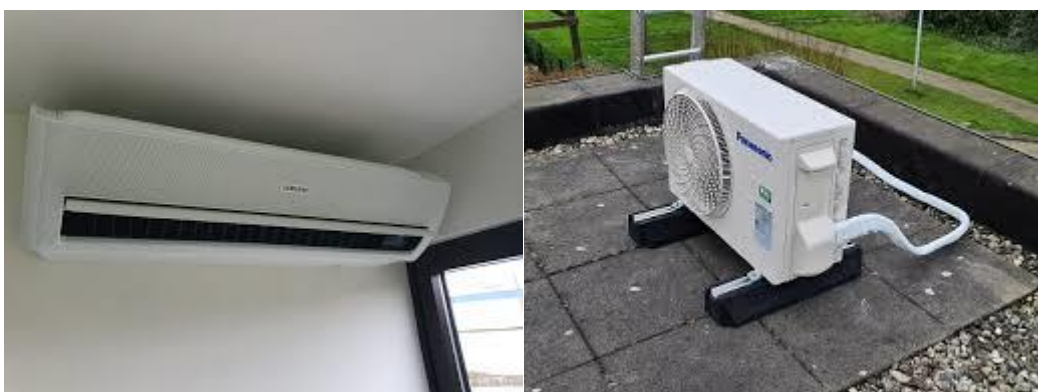
Split-system airco met aparte binnen- en buitenunit.
