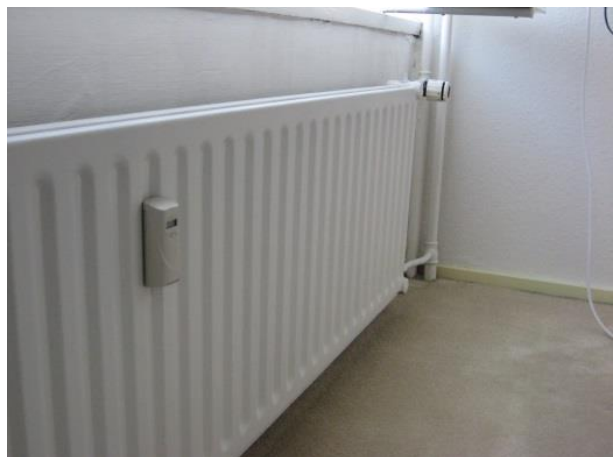
Foto 2-5: Stijg-/zakleiding per ruimte.
