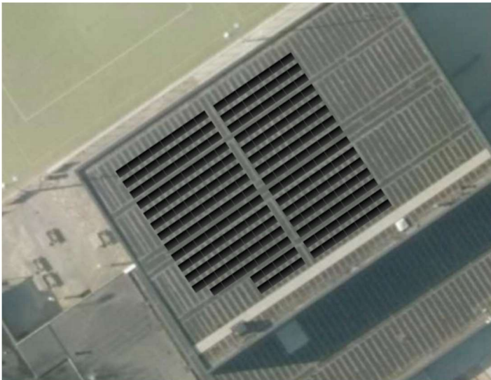
Weergave van de te realiseren zonnepanelen
