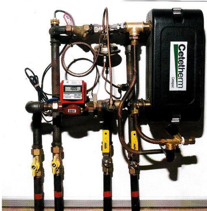
Zo simpel ziet een SV-huisaansluiting er uit
